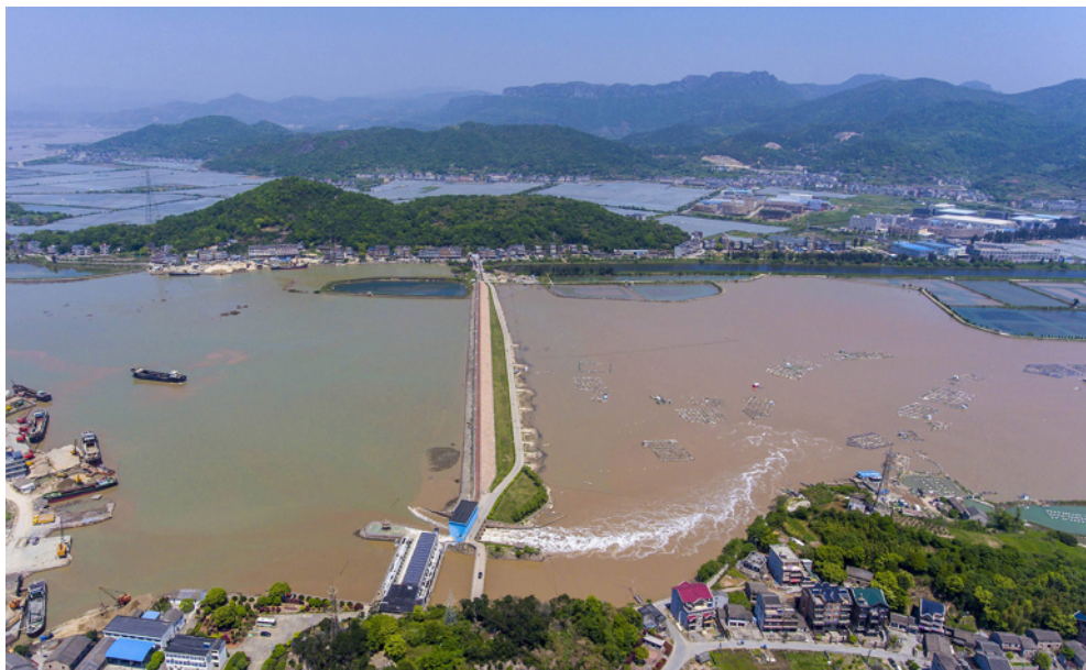
图2-2-10 浙江温岭江夏潮汐试验电站
