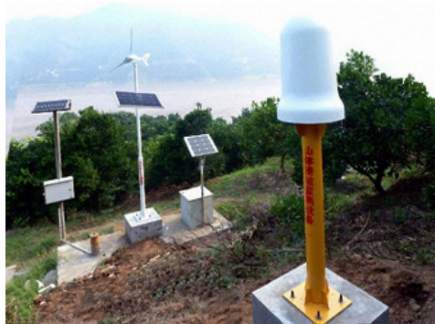
图4-3-8 卫星定位位移监测桩
